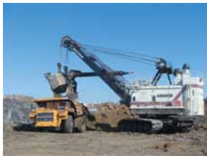
Монтаж экскаваторов отечественного и импортного производства
